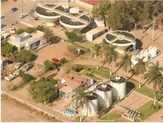
Sistema de clarificador con una batería de dos filtros integrados. Cap. 100 lps;
